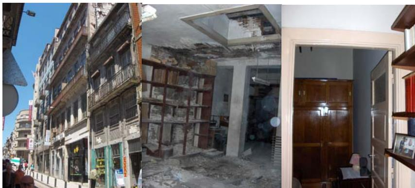
Na **parcela 009** existe um edifício com rés do chão e 3 pisos sem possibilidade de acesso aos 2 últimos pisos pois a escada não existe já. O edifício foi prolongado em profundidade no rés do chão e no piso 1, ocupando, esta ampliação, o logradouro na sua totalidade. O edifício está em muito mau estado de conservação.
