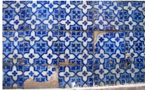
Figura 5: Azulejos com manchas e depósitos superficiais, lacunas no vidrado, fracturas e fissuras. Figura 6: Azulejos com manchas e depósitos superficiais, lacunas no vidrado, fracturas e fissuras.
