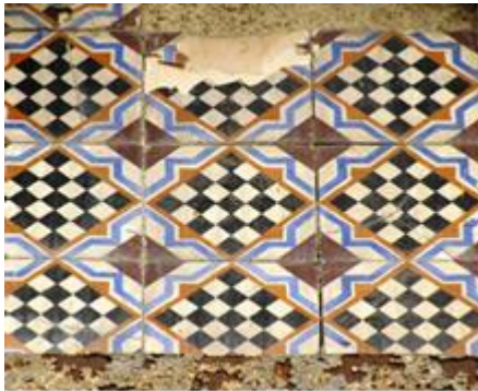
Figura 5: Azulejos com manchas e depósitos superficiais, lacunas no vidrado, fracturas e fissuras. Figura 6: Azulejos com manchas e depósitos superficiais, lacunas no vidrado, fracturas e fissuras.
